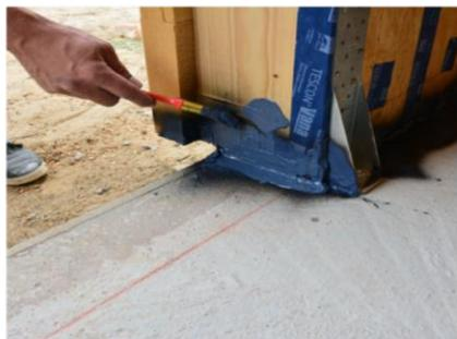
N.B. Se lo spessore dello strato di AEROSANA VISCONN è superiore a 1 mm, lasciarlo prima asciugare e poi continuare l'applicazione.
